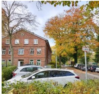
Umgestaltung Schulhof Grundschule Frohmestraße
